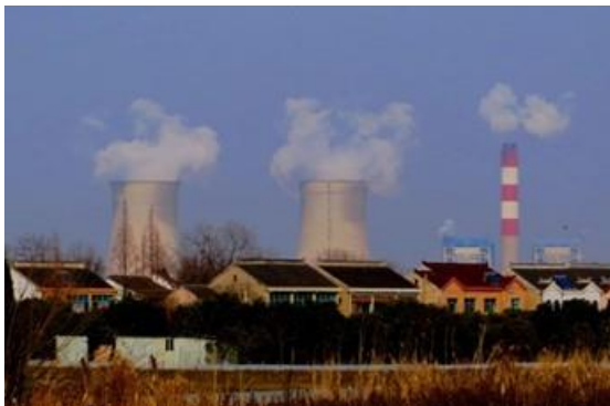
蘇州、無錫の街中に見られた発電所
